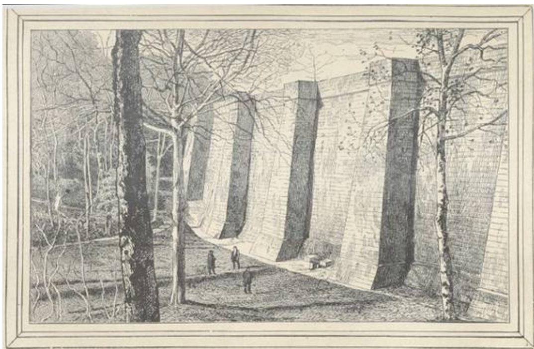
Figure 12 Grand mur du réservoir du Lampy
