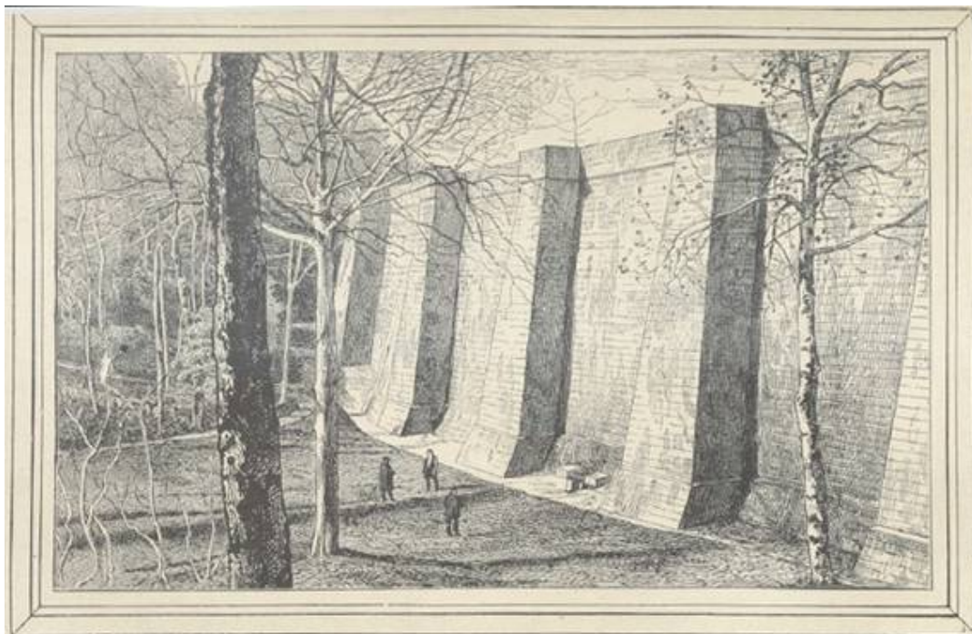
Figure 12 Grand mur du réservoir du Lampy
