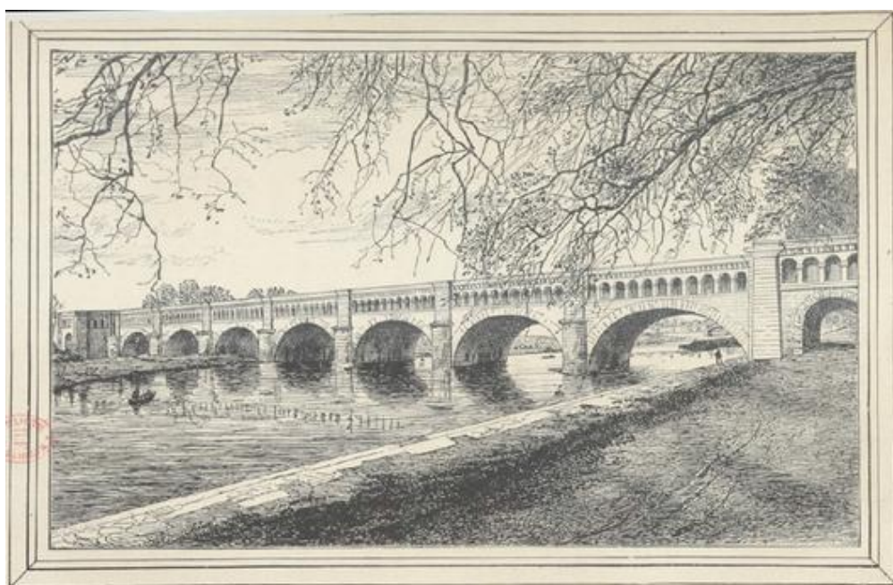
Figure 14 Pont du canal de Fresquel
