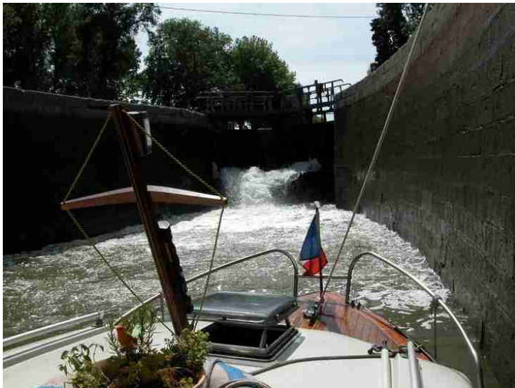
Remous dans l'écluse
